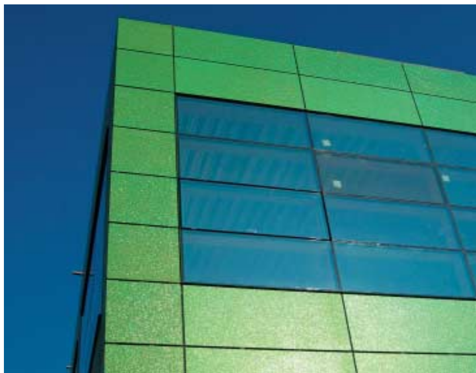
Voor de Brede School in Amsterdam Osdorp heeft de architect een gevelbeplating van hpl met glittereffect voor-gesteld. Foto Atelier Zeinstra Van der Pol
